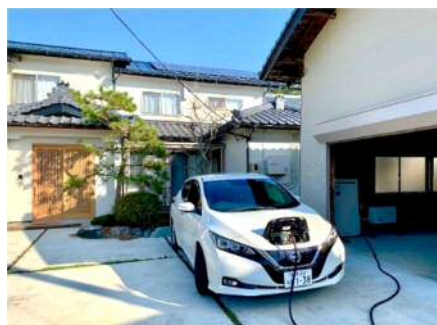
太陽光・蓄電池等完備のモデルハウス
